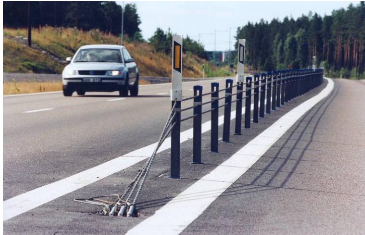
Mynd 3: Viraleiðarinn, stikur og festingar. Mynd frá Svíþjóð.
