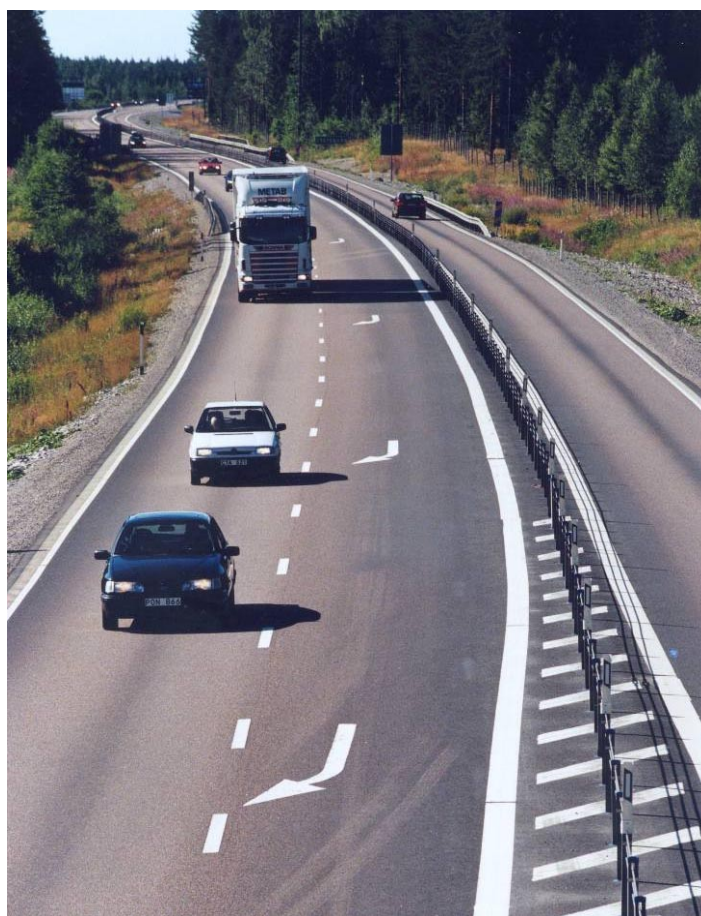
Mynd 7: 2+1 vegur með víraleiðara. Mynd frá Svíþjóð.
